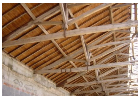
Fig. 36 – Ondutherm sobre estrutura existente
