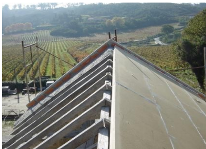
Fig. 42 – Remate das juntas com mástique
