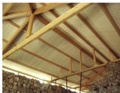
Fig. 37 – Ondutherm sobre estrutura nova
