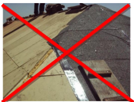
Fig. 45 – Aplicação de tela asfáltica colada por cima de painel Ondutherm
