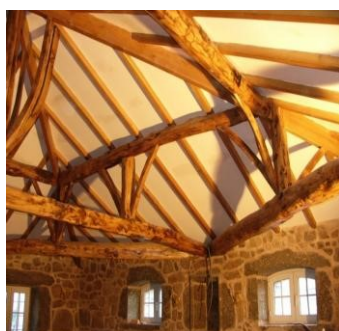
Fig. 38 – Aplicação de painel sobre estrutura de madeira
