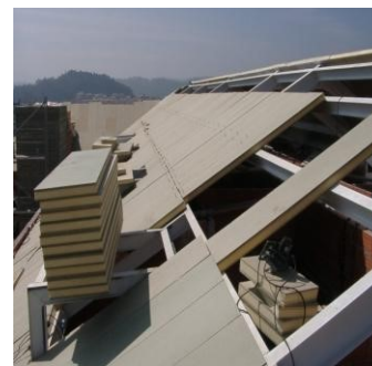
Fig. 40 – Aplicação de painel sobre estrutura metálica
