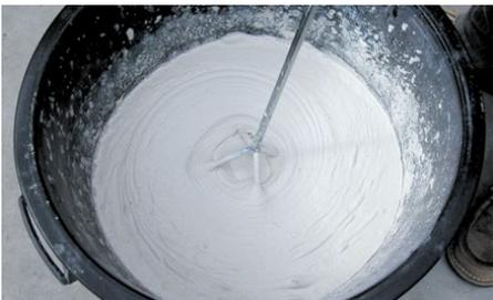
1. Misturar Topeca Restauro com cerca de 6lt de água por saco, manualmente ou com misturador elétrico de baixa rotação sem prolongar o tempo de amassadura, até obter uma mistura homogénea e sem grumos.
