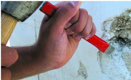
O suporte deve estar limpo, sólido, seco, isento de ferrugem, gorduras e óleos, sem partículas em desagregação, e quaisquer contaminações. O suporte deve apresentar-se rugoso. Sondar com martelo as zonas degradadas. Retirar todos os elementos de pedra degradada.
