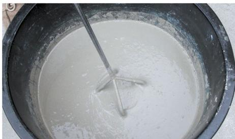
1. Misturar mecanicamente o conteúdo de um saco com cerca de 6 a 6,5 L de água limpa, até obter uma massa com consistência plástica e sem grumos.
