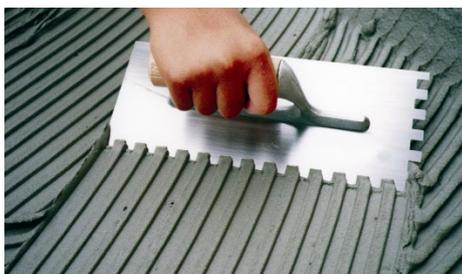
3. Colocar as peças sobre o cimento cola efetuando um ligeiro movimento perpendicular ao dentado, e bater as peças fortemente com recurso a um maço de borrada, de modo a conseguir o completo nivelamento dos sulcos e assegurar a total transferência da cola para o suporte e a peça. Respeitar as juntas entre peças, colocando cruzetas adequadas à sua largura.
