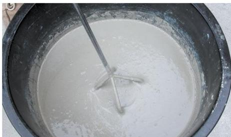
1. Misturar mecanicamente o conteúdo de um saco com cerca de 6 a 6,5 L de água limpa, até obter uma massa com consistência plástica e sem grumos.
