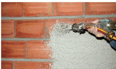
**2.** Aplicar Rebetop Ecolight projetando de baixo para cima sobre o suporte. Caso o nivelamento das paredes exija uma maior espessura de reboco, a aplicação deve ser feita em várias camadas deixando endurecer a anterior. Entre camadas, a anterior deverá ficar rugosa.
