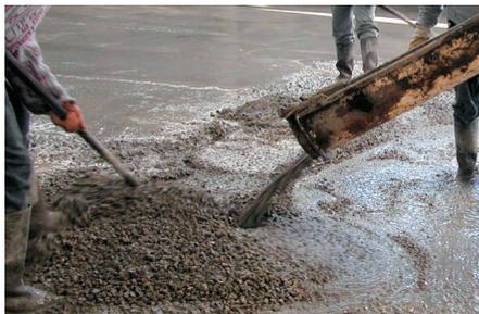
O betão deve ter uma espessura de pelo menos 10cm, a dosagem de cimento e a colocação de armaduras, deve ser adequada à utilização prevista para o pavimento (cargas previstas).
