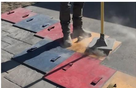
3. Colocar os moldes pressionando-os uniformemente com um pisa moldes, para que o desenho fique impresso de uma forma homogénea. Esta operação deverá ser realizada quando o betão adquire o grau de endurecimento correto. Caso o betão apresente uma consistência muito plástica (mole), o molde acaba por penetrar demasiado no betão, se por contrário o betão já apresentar um grau de endurecimento avançado irá dificultar a penetração do molde e a impressão do desenho.
