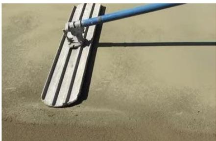
2. Aguardar que o Topeca Endur Impresso absorva a humidade do betão, penetrando no próprio, o que origina uma camada monolítica de elevada resistência. Passar com uma talocha de magnésio para compactar e alisar o Topeca Endur Impresso. Quando o betão iniciar o endurecimento polvilhar com o Topeca Floor Desmoldante para evitar a colagem dos moldes ao betão.
