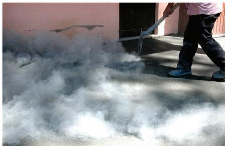
1. Aplicar o betão sobre o suporte a revestir, uniformizar com régua e passar com talocha de magnésio para alisar a superfície de betão. Sobre o betão fresco polvilhar com Topeca Endur Impresso recobrimdo a totalidade do pavimento, 4-6 kg/m<sup>2</sup> cobrindo totalmente o pavimento de betão.
