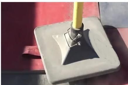
3. Colocar todos os moldes no pavimento e trabalhar sobre estes. Comprimir os moldes usando um pisa moldes. Quando terminarem os moldes retira-se o primeiro utilizado e coloca-se imediatamente a seguir ao último, e assim sucessivamente. Com o ferro de juntas aperfeiçoar as juntas dos moldes e retirar eventuais excessos com uma espátula.
