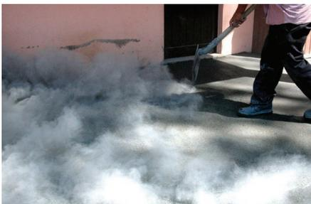
1. Quando o betão impresso se encontrar em estado plástico polvilhar a superfície e os respetivos moldes com Topeca Floor Desmoldante cobrindo completamente todo o suporte.
