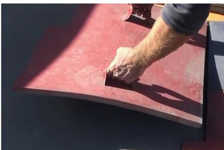
2. Imprimir o betão com os moldes selecionados. Normalmente são necessários 3 moldes + 1 molde flexível para os remates. Os moldes devem ser colocados em filas começando na área onde começou a betonagem ou onde o betão está a endurecer mais rápido.
