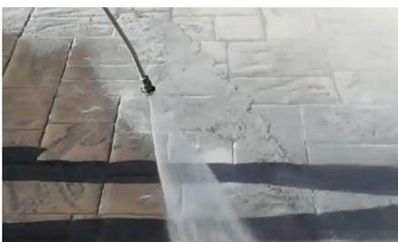
4. Após 72 horas eliminar o Topeca Floor Desmoldante varrendo e lavando com água à pressão (100-150 bar) em forma de leque e com uma distância adequada de forma a não danificar o suporte. Quando o pavimento estiver completamente seco e isento de humidade poderá aplicar um protetor de superfície (hidrofugante ou verniz) adequado obtendo um pavimento protegido contra o gelo, sujidades e de fácil limpeza.
