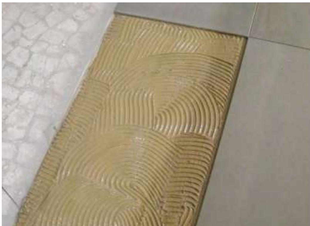
Figura 4.13 – Pavimento Viroc apoiado em suporte contínuo
