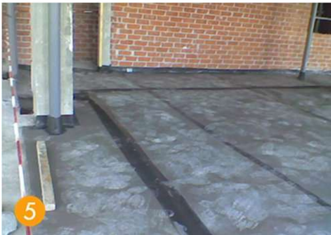
Estender Selar sobreposição sobreposição vertical Proteger instalações verificar verter a argamassa
