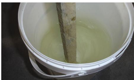
1. Os agregados naturais deverão ser lavados, secos e deverão ter uma granulometria entre 2/6 mm e 32/56 mm. Misturar previamente o Componente A e B, caso pretenda que o produto tenha um endurecimento rápido.
