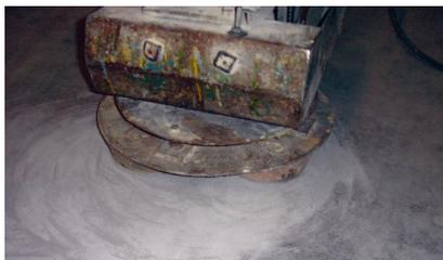
O pavimento a revestir deve estar, isento de elementos soltos, sujidades, óleos, ceras e não ser vidrado etc. Em casos de pavimentos vidrados deve proceder à abertura do poro, de modo a criar pontos de ancoragem para o Topeca Floor OUT.
