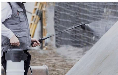
**1.** Aplicar o Descofrante Topeca tal e qual ou diluído no interior dos moldes, com auxílio de uma trinca/pincel ou por pulverização.
