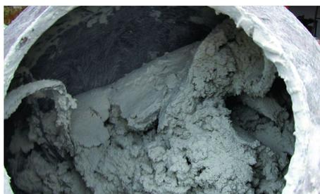
1. Misturar **Micro-Top** com cerca de 3,5-4,5 litros de água por saco até obter uma argamassa consistente e homogénea. Poderá aditivar com fibra metálica ou fibra de vidro - ver capítulo - Máquinas, Ferramentas e Acessórios.
