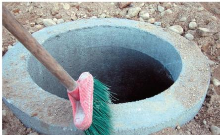
O suporte deve estar sólido, resistente e limpo. Eliminar o pó do suporte e dos elementos a selar com uma escova ou ar comprimido. Para favorecer a selagem, molhar o suporte e esperar que o filme de água desapareça. Os elementos a selar devem estar isentos de óxidos ou ferrugens.
