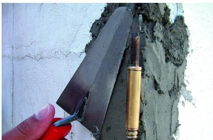
3. Nivelar e alisar rapidamente com uma talocha ou colher de pedreiro. Poderá dar um acabamento liso, areado, etc. No caso de pretender outro tipo de acabamento deverá deixar cerca de 1cm de profundidade livre.
