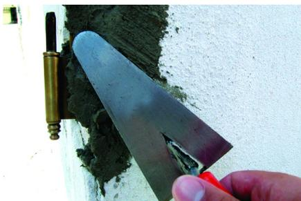
2. Aplicar o produto com uma colher de pedreiro, imediatamente após a mistura. Encher bem o orifício até ao fundo. Inserir o elemento a selar e comprimir, este deverá ficar imobilizado até ao endurecimento da argamassa.
