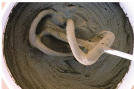
1. Misturar Argamassa de Fixação Rápida em pequenas quantidades. Para 1Kg de produto deve adicionar cerca de 200ml de água, misturando manualmente até obter uma pasta homogénea e sem grumos. Para quantidades superiores a 1 Kg e tempos superiores a 5 minutos, deverá adicionar à Argamassa de Fixação Rápida a quantidade de regulador de tempo adequado à situação. Adicionar a quantidade de água correspondente e misturar mecanicamente ou manualmente até obter uma pasta homogénea e sem grumos.
