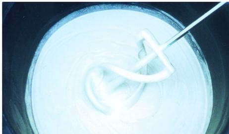
1. Misturar de preferência mecanicamente (velocidade lenta) Tuforte Adesivo com cerca de 10 litros de água por cada saco de 20 kg, até obter uma pasta de consistência plástica.
