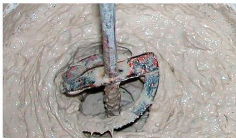
1. Verter o pó progressivamente em cerca de 8 litros de água limpa. Deixar repousar cerca de 2 a 3 minutos. Misturar mecanicamente (500rpm) de forma a obter massa com consistência plástica.
