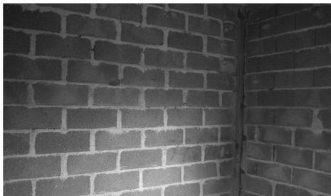
Aplicar sobre superfícies resistentes, isentas de pó, gordura e sem humidade. Em superfícies antigas, fazer uma limpeza profunda dado que a cola vai ser aplicada diretamente sobre a parede.
