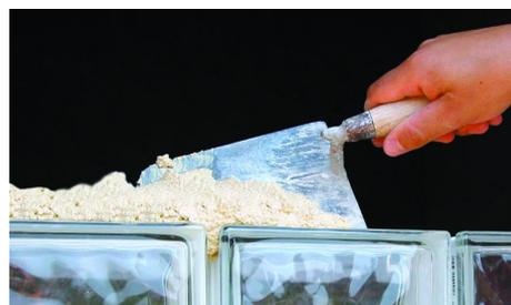
3. Encher bem as juntas de dilatação/assentamento com uma espessura de pelo menos 3 cm, colocando as varinhas no interior. Aplicar a massa sobre o bloco de vidro de modo a garantir o enchimento da junta. Comprovar que o tijolo está rodeado de material bem distribuído. Eliminar o excesso de massa com a ajuda da colher de pedreiro.
