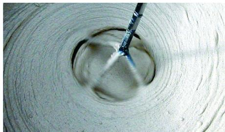
1. Misturar mecanicamente 25Kg de produto com 4,5-5,5 litros de água limpa até obter uma massa homogênea e sem grumos. Poderá utilizar um corante em pó para adicionar ao Topeca Glass Block, de modo a obter juntas da cor desejada.
