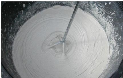
**1.** Misturar mecanicamente o Rebetop Decor de forma a homogeneizar o produto. No caso de lotes distintos, verificar a uniformidade da cor entre baldes.
