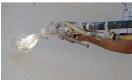
2. De seguida aplicar a segunda camada de enchimento projectando o Rebetop Kal com força e apertando bem contra o suporte. Incorporar rede fibra de vidro nesta camada. Aplicar nova camada de Rebetop Kal até obter a espessura desejada. Entre camadas deixar a anterior rugosa.
