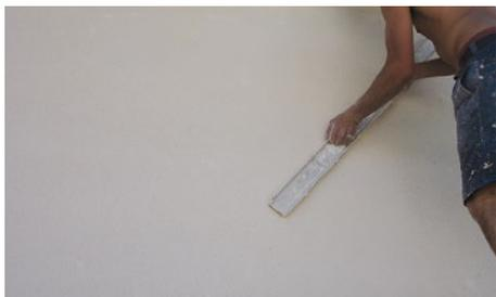
3. Após projecção regularizar com régua de alumínio H fechado, apertar bem a massa, de modo a obter uma superfície plana. Entre camadas deixar endurecer a anterior, ou seja deixar que ocorra a retracção por secagem da argamassa.
