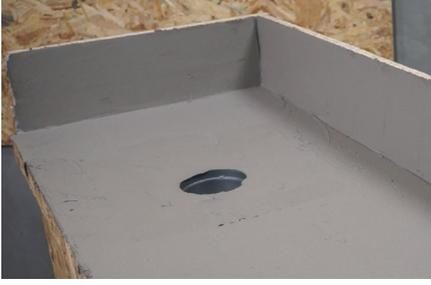
O suporte deve estar curado, resistente, plano, seco e limpo (isento de pó, óleos descolorantes, eflorescências, etc.). Dependendo do suporte poderá ou não ser necessário aplicar um primário previamente à colagem da banda. Para o efeito consultar a Ficha Técnica da membrana impermeabilizante.
