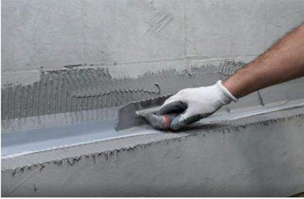
1. Amassar a membrana impermeabilizante de acordo com as instruções da respetiva Ficha Técnica, para colagem da banda.
