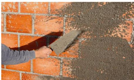
1. Amassar, de preferência mecanicamente, em máquinas com doseamento automático de água, regular o caudal de forma a obter uma argamassa com consistência plástica. Em máquinas sem doseador de caudal de água, misturar o Rebetop Chapisco com cerca de 8.5 litros de água limpa por saco, até obter uma massa de consistência plástica.
