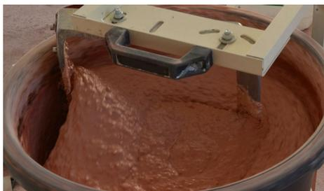
1. Homogenizar bem o Topelastic traffic antes da sua aplicação. Aplicar o Topelastic Traffic com rolo de pelo curto, talocha de inox ou trincha, sobre toda a superfície. Para uma melhor impermeabilização recomendamos a aplicação em três camadas cruzadas, sendo a 1ª camada diluída entre 15-20% (para melhorar a aderência ao suporte) a 2 e 3ª aplicadas sem diluição, respeitando os tempos de espera entre camadas. Intervalo entre camadas é no mínimo de 16 horas.
