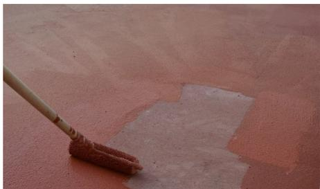
2. Caso seja necessário aplicar a rede fibra de vidro (p.ex. suportes fissurados) esta deve ser estendida sobre a segunda camada de Topelastic Traffic, e selada com a terceira camada. Aconselha-se a aplicação de várias camadas até perfazer os 2mm de espessura.
