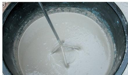
**1. Primário:** Misturar o componente A com B, na proporção indicada, adicionar mais 5% de água à mistura do Topelastic (A+B), obtendo assim o primário com consistência apta para aplicação com rolo ou trincha.
