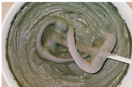
1. Amassar a Argamassa Anti-Humidade Capa Fina, com um misturador de velocidade lenta, com cerca de 6,5 litros de água por saco, até obter uma massa com consistência plástica.
