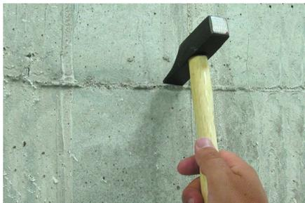
Os suportes devem estar limpos, resistentes, sem óleos descofrantes e regularizados. Recomenda-se a lavagem a alta pressão ou com jato de areia. Eliminar toda a ferrugem das armaduras com uma escova metálica. Eliminar sujidades vegetais com Topnet.
