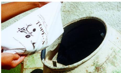
1. Misturar os vários componentes da argamassa, em seco, incluindo o aditivo impermeabilizante, conforme descrito nos pontos abaixo.
