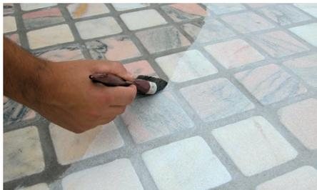
1. Passar uma demão de Silitop Wet sobre o pavimento com a ajuda de uma trincha, rolo ou pulverizador. Aplicar de maneira uniforme e contínua.
