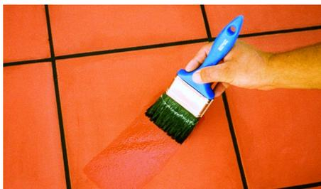
1. Aplicar o Silitop B3 com trincha, rolo ou com um pulverizador de baixa pressão, em 2 a 3 camadas.
