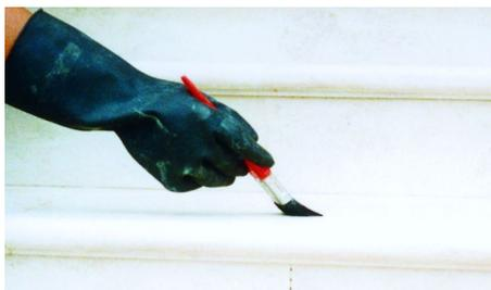
1. Aplica-se à trincha, rolo ou em pulverização de baixa pressão, de baixo para cima até à saturação do suporte. Aplicar em 2 ou 3 demãos, húmido sobre húmido.
