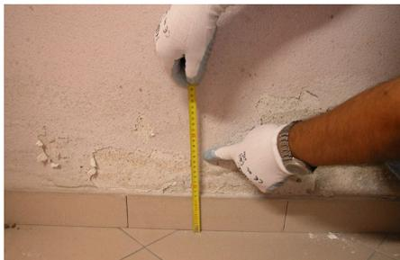
O reboco degradado, solto e com elevada carga de sais deve ser retirado por picagem até 50 cm acima da parte húmida visível. Em paredes intactas e sólidas não é necessário remover o reboco.
