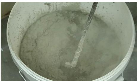
1. Com um misturador elétrico a baixa rotação (500 rpm) misturar o conteúdo de um saco com a quantidade de água limpa abaixo tabelada, de acordo com a espessura a aplicar, até obter uma argamassa fluida, homogênea e sem grumos. Como alternativa poderá utilizar uma máquina de mistura e bombagem, controlando devidamente o caudal de água em função da consistência.
