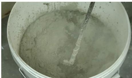
1. Amassar um saco de Autonivelante Nível S com 9 a 10 L de água limpa, com recurso a um misturador elétrico de baixa rotação (500 rpm), até obter uma argamassa fluida, homogênea e sem grumos.
