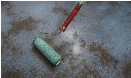
Garantir que o suporte está resistente, plano, seco e limpo, isto é, isento de pó, óleos, gorduras, materiais desagregados ou outro tipo de sujidades. Os pavimentos de betão e betonilha devem apresentar resistência à compressão superior a 12 N/mm<sup>2</sup>.
