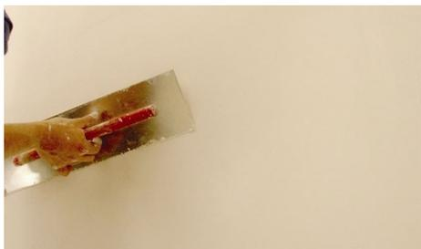
3. Aplicar o Tuforte Barramento em uma ou várias camadas com a ajuda de uma espátula ou talocha metálica. Poderá ser aplicado em diversas camadas cruzadas. O tempo de espera entre cada camada depende: da temperatura ambiente, do tipo de suporte, e da espessura da camada anterior.
