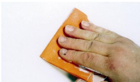
4. Depois de seco, se necessário aperfeiçoar a superfície com uma lixa. Depois de completamente seco poderá revestir com tinta, papel ou revestimentos orgânicos.
