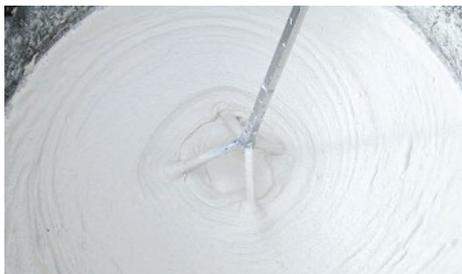
1. Verter o pó progressivamente sobre a água, misturando um saco de Tuforte Barramento com cerca de 13 a 14 litros de água limpa, e deixar repousar entre 2 a 3 minutos.
