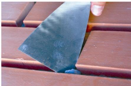
As juntas devem estar secas, isentas de cola, cimento e de pó. Limpar gretando se necessário. Esta condição permite garantir uma boa aderência, uma boa secagem e homogeneidade de cores.
