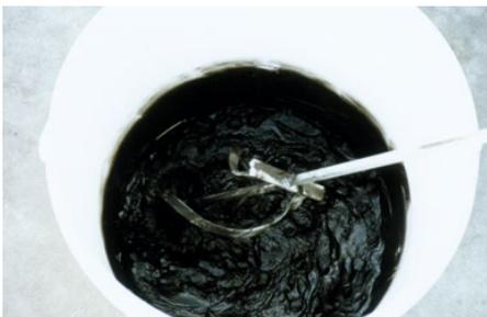
1. Amassar Juntaemcor Plus+, com cerca de 6 litros (como dado orientativo para juntas de 5mm) de água limpa por cada saco de 25 kg, manualmente ou com um misturador de velocidade lenta, até obter uma pasta homogénea e sem grumos.
